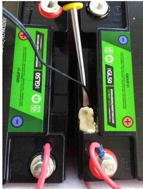
Abbildung 14: Entfernen Sie den Temperatursensor
