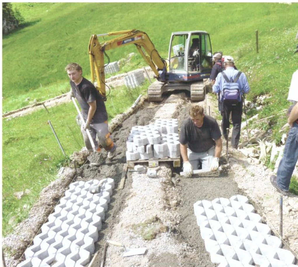
Wegbau mit Rasengittersteinen im Gebiet Fräkmünt der Pilatusalpen; Arbeiten im Rahmen des PRE Pilatusalpen, 2011. (F. Wirz, BLW)
